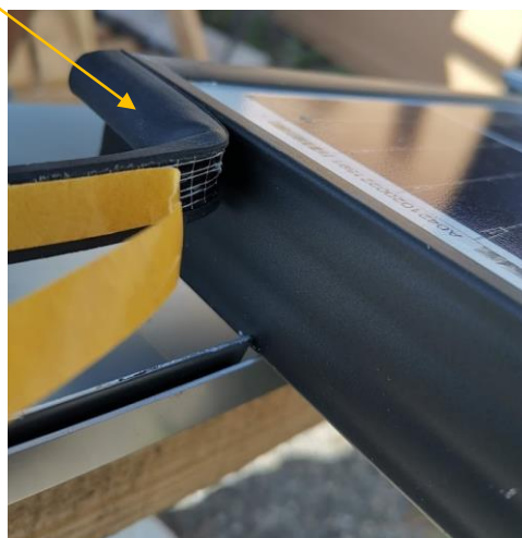
Vue en coupe du cadre et positionnement du joint
